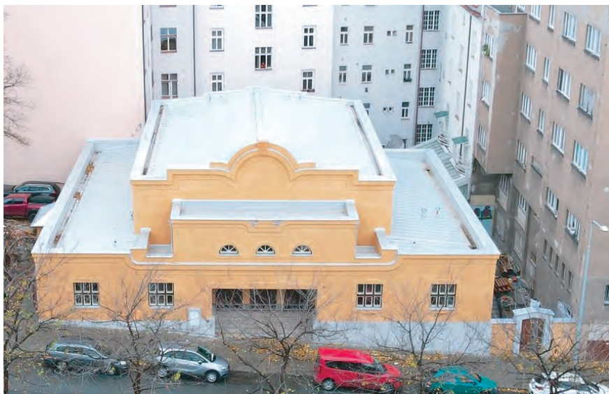
Novostavba Žižkova sboru v Praze-Žižkově realizovaná v letech 2020–2024 podle původního návrhu Františka Kaliby
